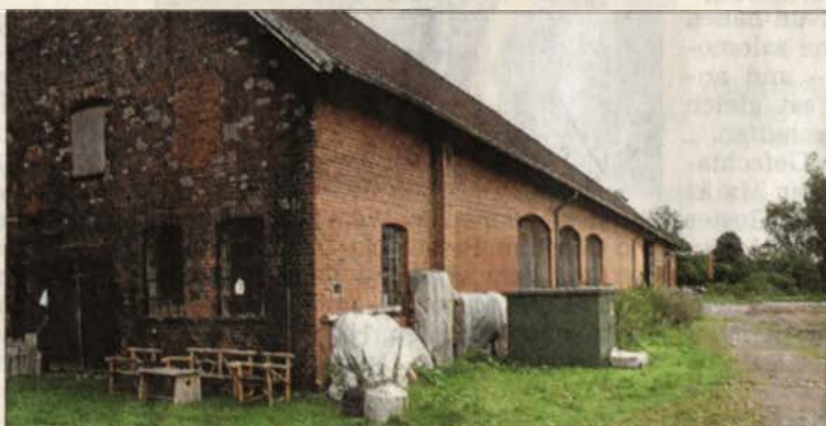
An der Südscheune auf dem Bliestorfer Gutsgelände sollen im Oktober die ersten Umbauarbeiten beginnen.
